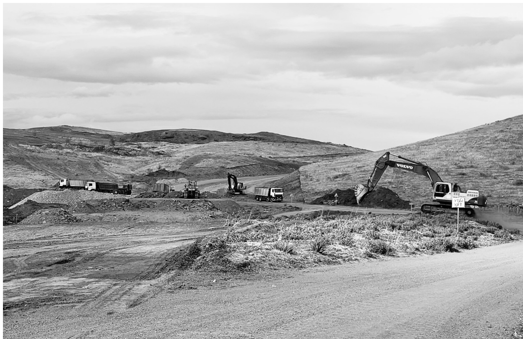
Строительные работы ведутся с опережением графика
